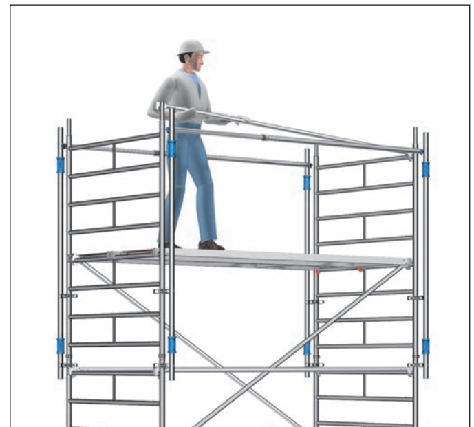
Bild 6: Sichere Montage der Rückenlehnen mit MSG
