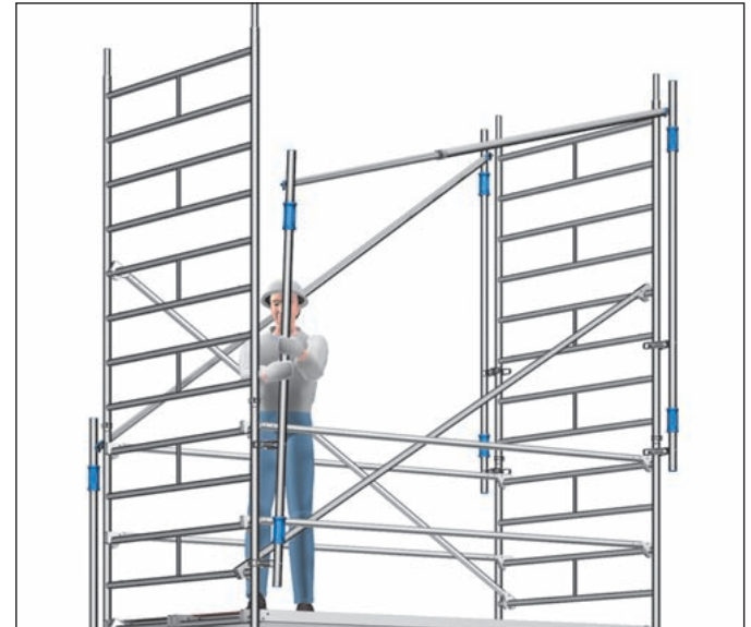
Bild 5: Versetzen des MSG nach oben
