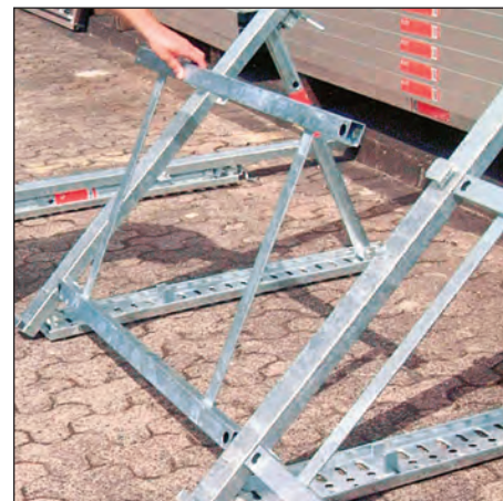
Einlegen der Aussteifungsrahmen
