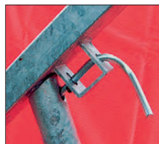
Verriegelung der Böcke (bei eingebauten Platten kann diese nicht gelöst werden)
