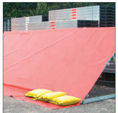
Beschweren der Dichplane mit Sandsäcken
