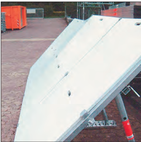
Untere und obere Plattenlage der Hartschaumplatten
