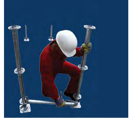
Rohrriegel 75 über die untersten Lochscheiben schieben und mit einem Hammerschlag verkeilen
